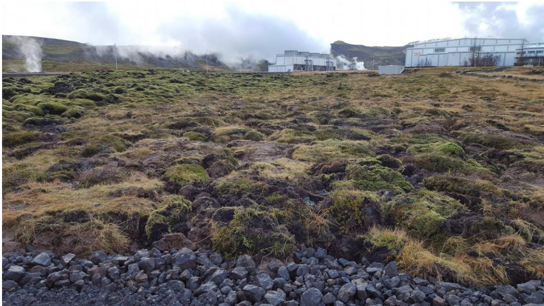
Mynd 4.6 Dæmi um frágang á eldra raski við Nesjavallavirkjun. Gróðurtorfur sem að ekki nýtast í viðkomandi verki eru fluttar á önnur svæði til að ganga frá eldra raski t.d. malarplönnum sem notuð voru við boranir.
